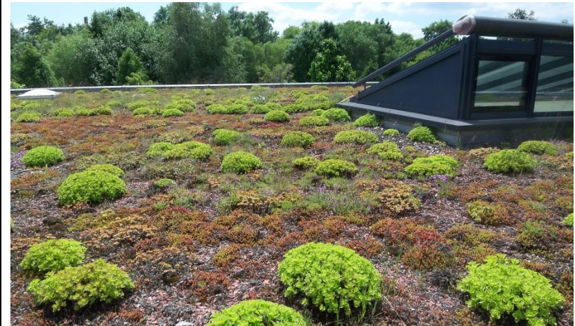
Bild: Extensive Dachbegrünung auf dem Umweltzentrum (Quelle: © Stadt Hanau)
