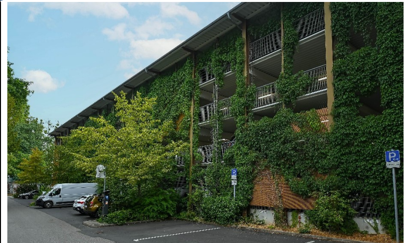
Bild: Fassadenbegrünung am Parkhaus Congress Park/Am Schwimmbad (Quelle: © Stadt Hanau)
