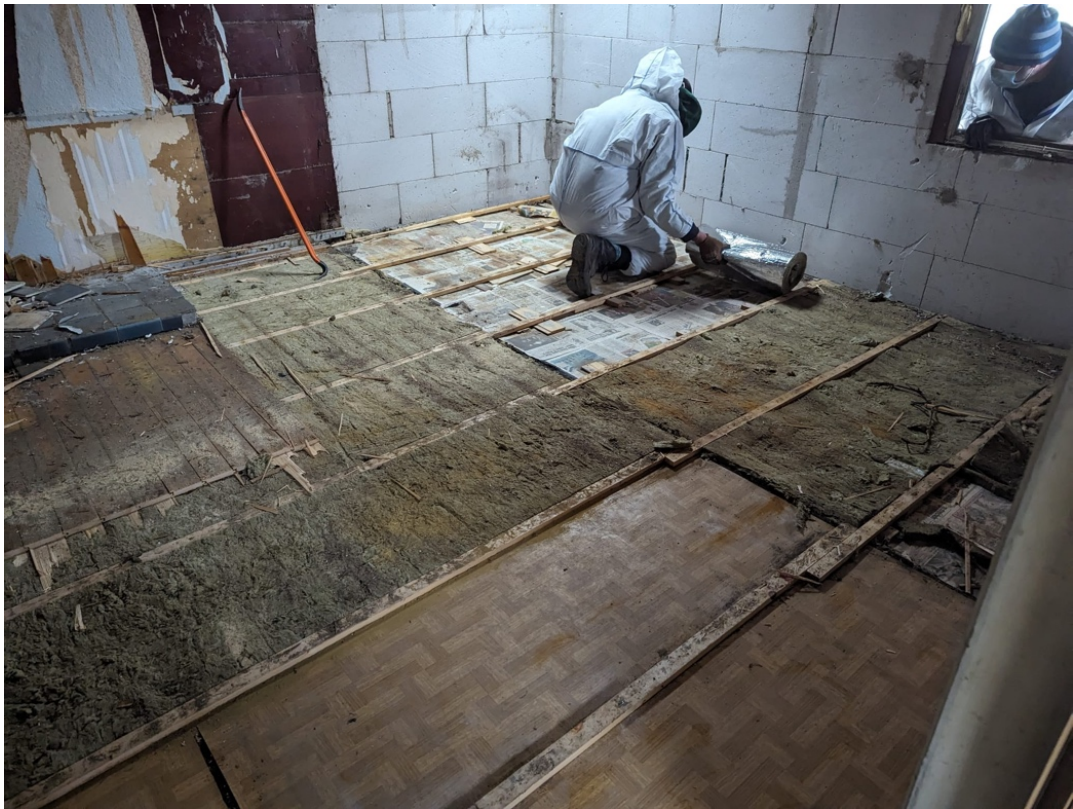
Foto: Fachgerechte Entsorgung asbesthaltiger Materialien beim Rückbau einer gemauerten Gartenhütte
